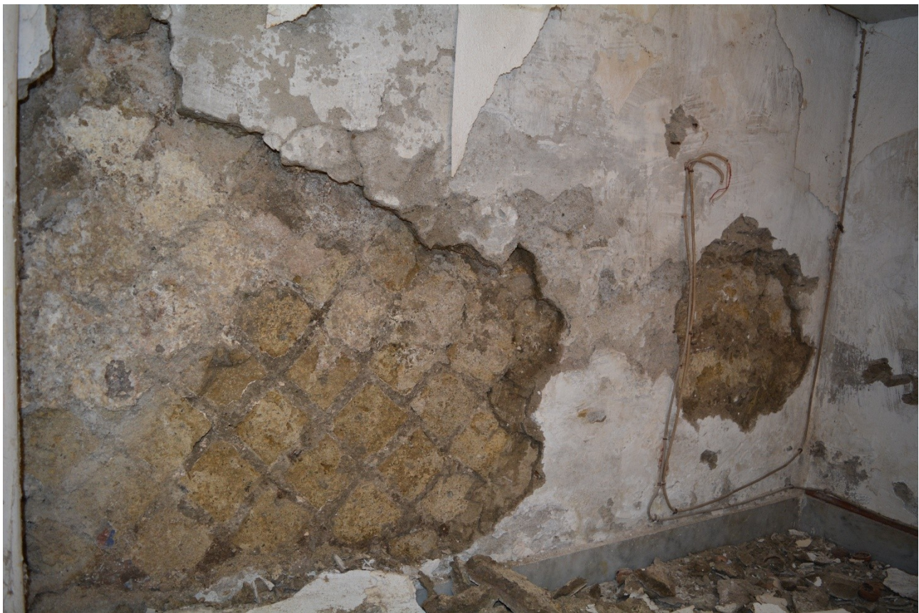
Muro in opera reticolata
