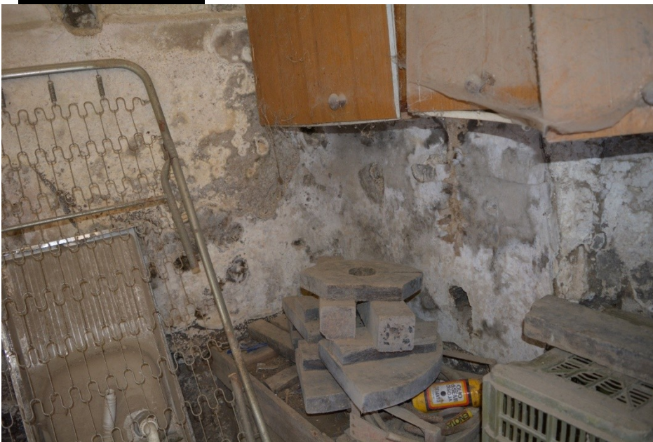
Parete della cisterna con rivestimento in cocchiopesto ed angolo arrotondato.
