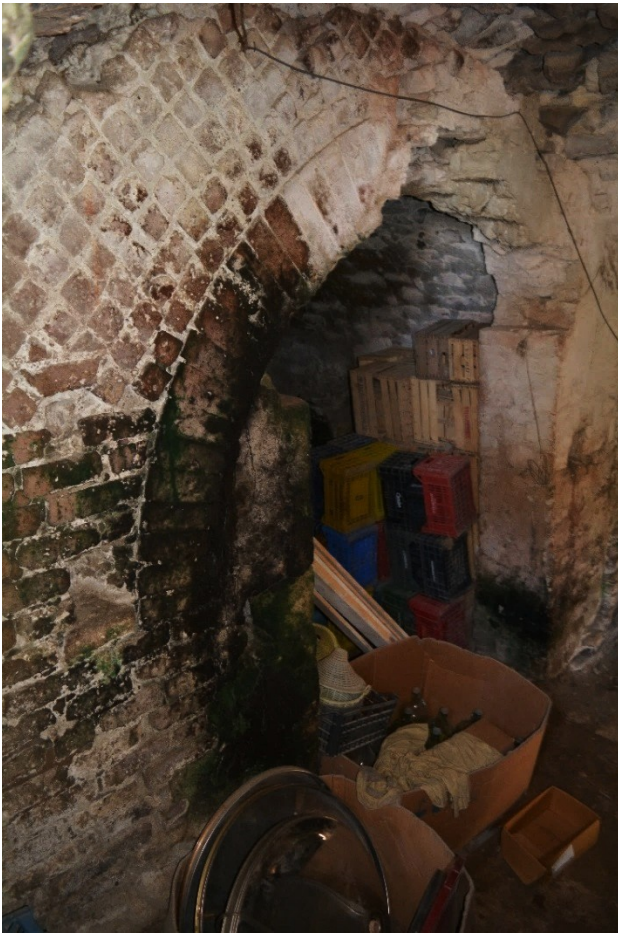
Cellaio seminterrato con volta a botte e pareti in opera reticolata (opus reticulaum) e vittata (opus vittatum)
