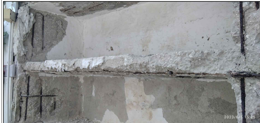
Setti dei loculi da risanare, a seguito di rimozione delle parti friabili o degradate.
