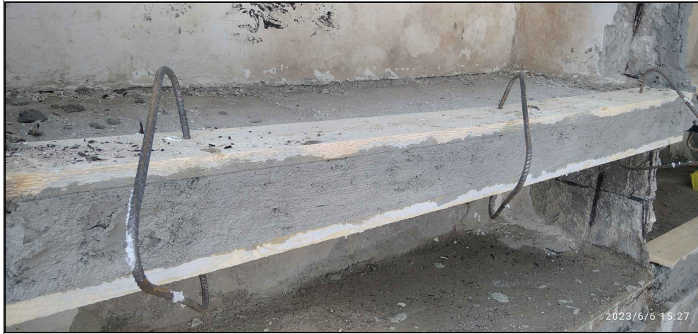
Setti dei loculi da risanare, a seguito di rimozione delle parti friabili o degradate.
