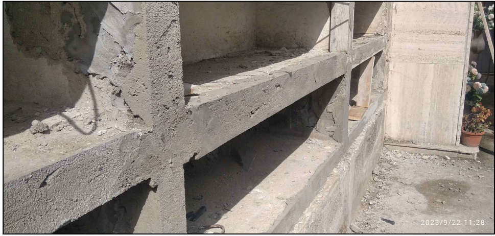
Ricostruzione della geometria originale dei setti verticali ed orizzontali con uso di cemento classe M15 o con analoghe prestazioni meccaniche.
