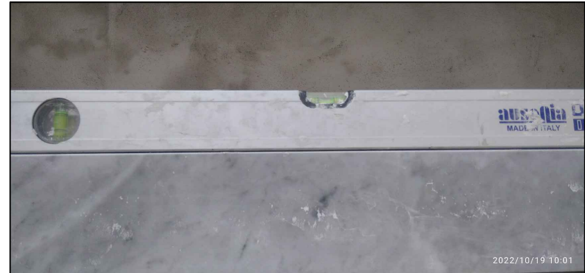
Posa in opera delle parti in marmo, previo livellamento del piano di posa.
