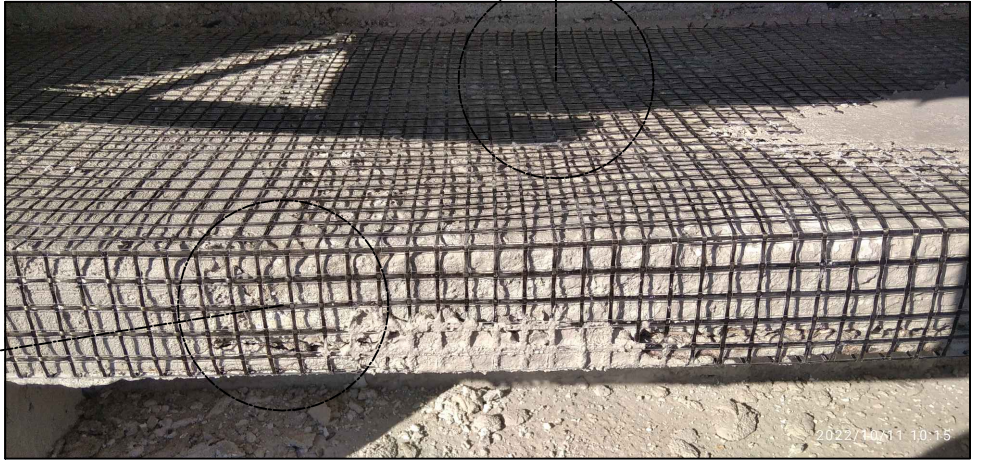
Posa in opera delle reti che contiene il piano verticale e orizzontale senza soluzione di continuità
