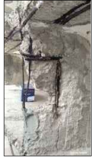
Posa in opera delle reti che contiene il piano verticale e orizzontale senza soluzione di continuità
