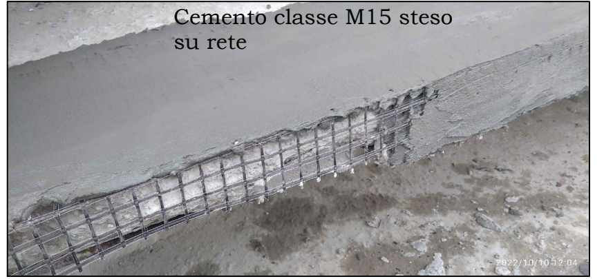
Ricostruzione della geometria originale dei setti verticali ed orizzontali con uso di cemento classe M15 o con analoghe prestazioni meccaniche.
