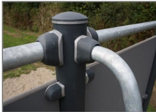
I connettori sono realizzati in alluminio pressofuso, appositamente legati per gli ambienti esterni e l'uso intenso. Le viti che fissano i connettori sono in acciaio inossidabile e protette da rondelle di zinco.
