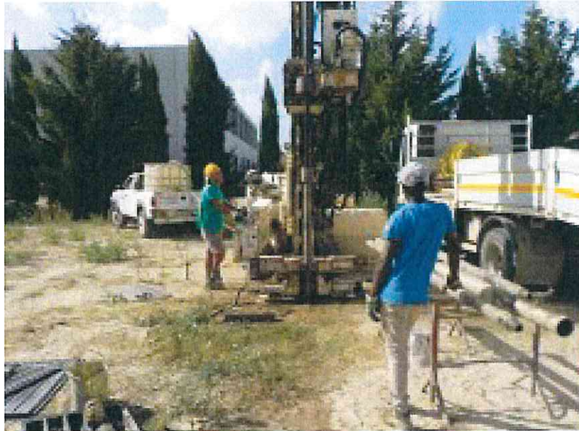
Fig.3-Postazione sondaggio a carotaggio continuo
