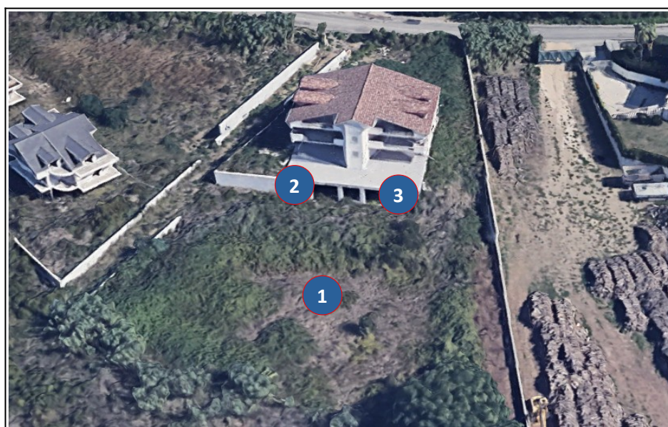
Figura 2 – Punti di misura presso la scuola De Santis, Via Campana 2H, Quarto (NA)
